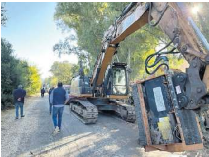
I mezzi che da ieri stanno provvedendo e risistemare l'asfalto
