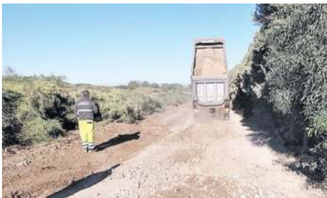
I lavori nella strada per Maimoni
